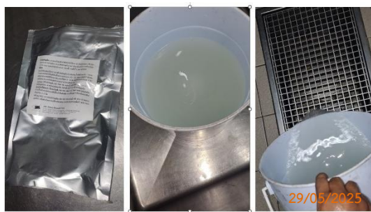
รูปที่ 2-25 การดูแลทำความสะอาดบ่อดักไขมัน
